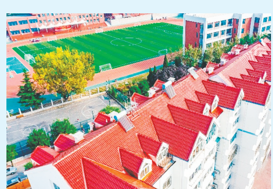
惠安社区完成改造后的屋面。
