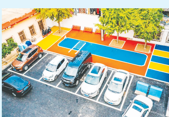
向阳社区完成改造后新增的停车位。
