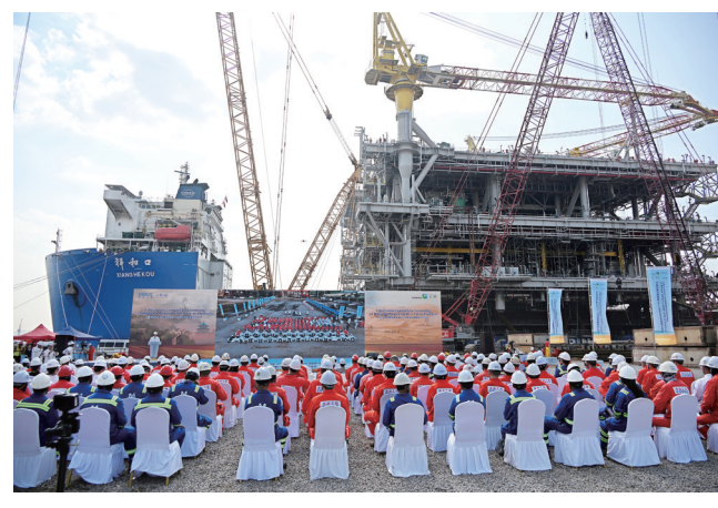
8月12日，各方代表在海洋石油工程(青岛)有限公司生产基地参加平台交付仪式。当日，由海洋石油工程(青岛)有限公司承建的沙特阿美与赞油气集输平台在山东青岛完工交付。该平台主要负责将开采出的海洋油气汇集并输送到陆地进行处理，每年可汇集输送原油2400万吨、伴生气74亿立方米；平台重量超过17200吨，高度超过24层楼，甲板面积相当于约15个篮球场。新华社
