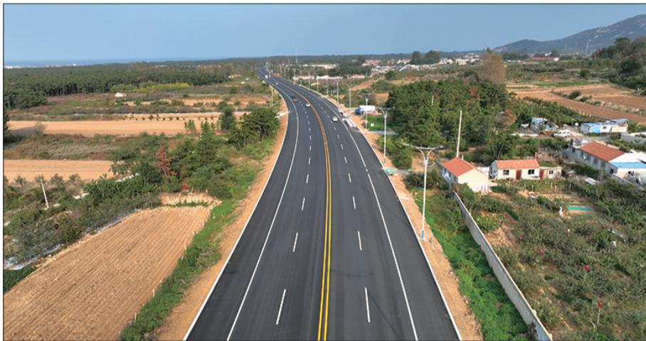
漫车行道的问题,将本次罩面路段K0+070—K0+440段进行抬高处理,提高路段标高,高尔夫路以西路段人行道、非机动车道进行恢复处理,并对抬高段增设一条D800雨水管线,同时对道路重新进行交通标志、标线、信号灯作业施工。
