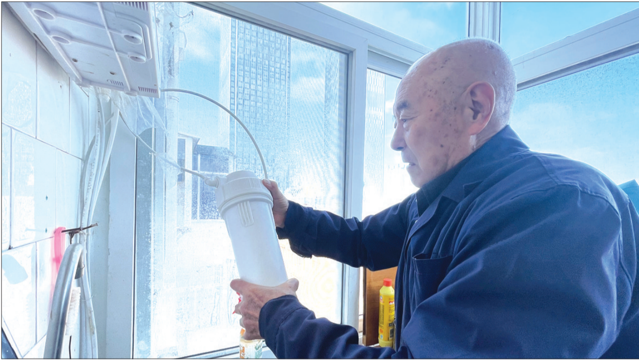
孙德荣在更换净水器滤芯
