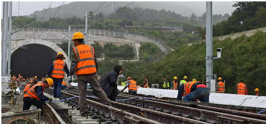
及钢轨拆除、材料倒运、电缆井埋设、电缆敷设、栅栏拆除等工作有序开展,确保当天的施工任务可以准时完成。
