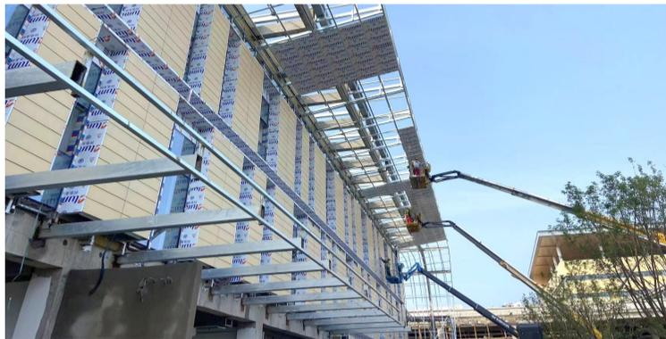
本报讯(YMG全媒体记者杨春娜 通讯员 由春艳 摄影报道)昨天上午,记者来到黄渤海新区大季家街道拉萨大街与大季家路交会处,烟台西站综合交通枢纽工程正在紧张施工中。工程主体已经完工,正在进行运营综合楼室内精装修、外幕墙玻璃安装施工,换乘大厅室内精装修、钢结构雨棚和外立面干挂石材施工。
