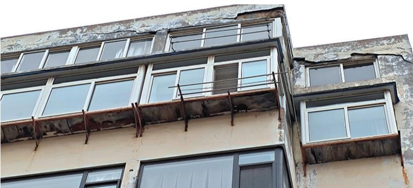
居民们十分不解,既然是旧改工程,整个小区为何独留这一栋楼不改造?大家多方打听得知,施工人员准备改造屋顶、粉刷外墙时,发现该楼的外墙水泥剥落脱落,确认该楼是栋“危房”,出于安全考虑就停止了施工。
