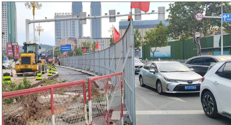
本报讯(YMG全媒体记者 杨健 通讯员 吴秀林 张洋 摄影报道)备受市民关注的芝罘区海港路(西大街-北马路段)两侧拓宽工程，伴随灼灼夏日进入“会战”。记者13日从现场获悉，率先施工的海港路东半幅，已经完成110米钢筋混凝土结构层，同步更换地下雨水管和部分窨井，整个东半幅施工将于9月底全面完工。届时，原本封闭的东半幅将撤去围挡，新增一条车道供市民通行，并开启西半幅地下及路面作业，11月中旬，拓宽至双向八车道的海港路，将正式“还路于民”。
