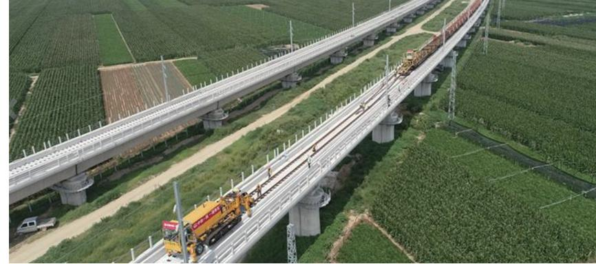
通。届时，潍烟高铁全线铺轨工程将全部完成。长轨贯通后将及时推进焊轨和应力放散工作，确保实现全线静态验收和联调联试等重要节点目标。”中铁一局潍烟铁路四标铺轨工区负责人曹德志介绍说，自开铺以来，各参建单位紧密配合，提前完成双线340铺轨公里施工任
