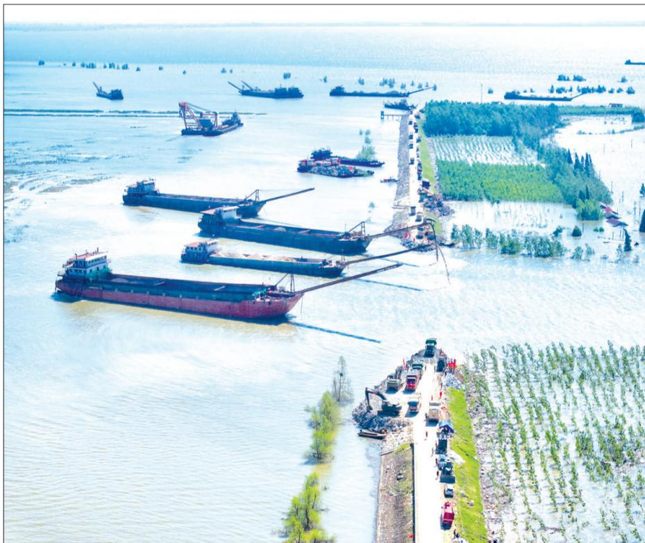
7月7日，在洞庭湖大堤决口现场，抢险队伍在进行堵口作业(无人机照片)。
