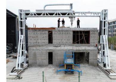
近日，在湖北宜昌三峡大学3D打印研发基地试验场，一栋由学校自行研发的12米级龙门式建筑3D打印机建设的双层小楼实现封顶，正在进行斜坡屋顶的施工安装。这栋双层小楼高8米，占地100平方米，比传统建造工期缩短约70%。
