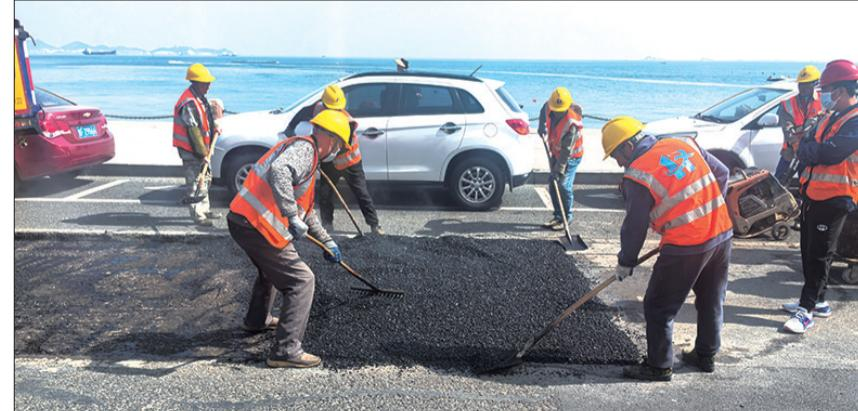
治。对已出现较大病害的路段,采取热沥青进行高精度修复。施工过程中严格执行“铣刨-基底处理-摊铺-碾压”标准化流程,对病害路面的边角进行精细化切缝处理,确保修补面几何线形平顺美观。通过精细化施工管理,实现功能修复与路面美观双达标,切实提升道路通行品质。
